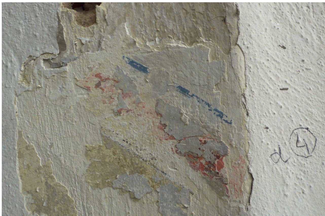
sonda 4 m 2.01d: zbytky dekorativní výmalby na klasicistní štukové vrstvě
