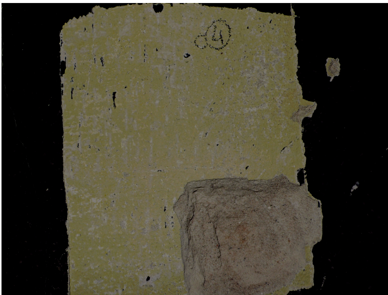
sonda 4 m 2.01c: zbytky výmalieb na klasicistní štukové vrstvě
