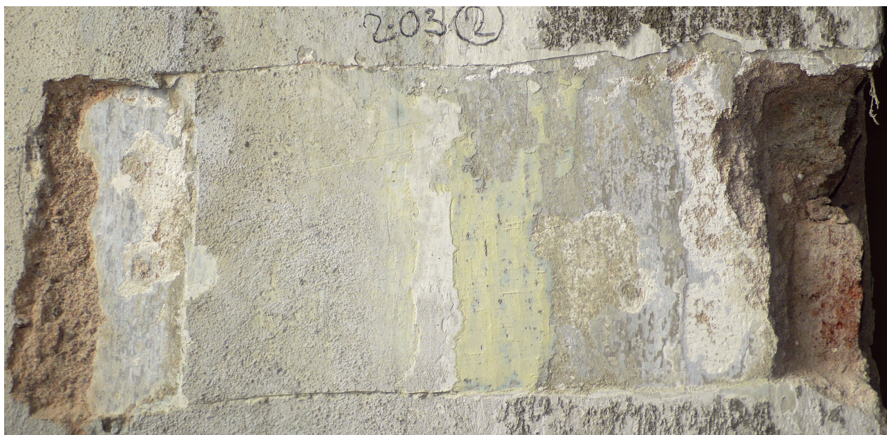
sonda ve špaletě okna m 2.03
