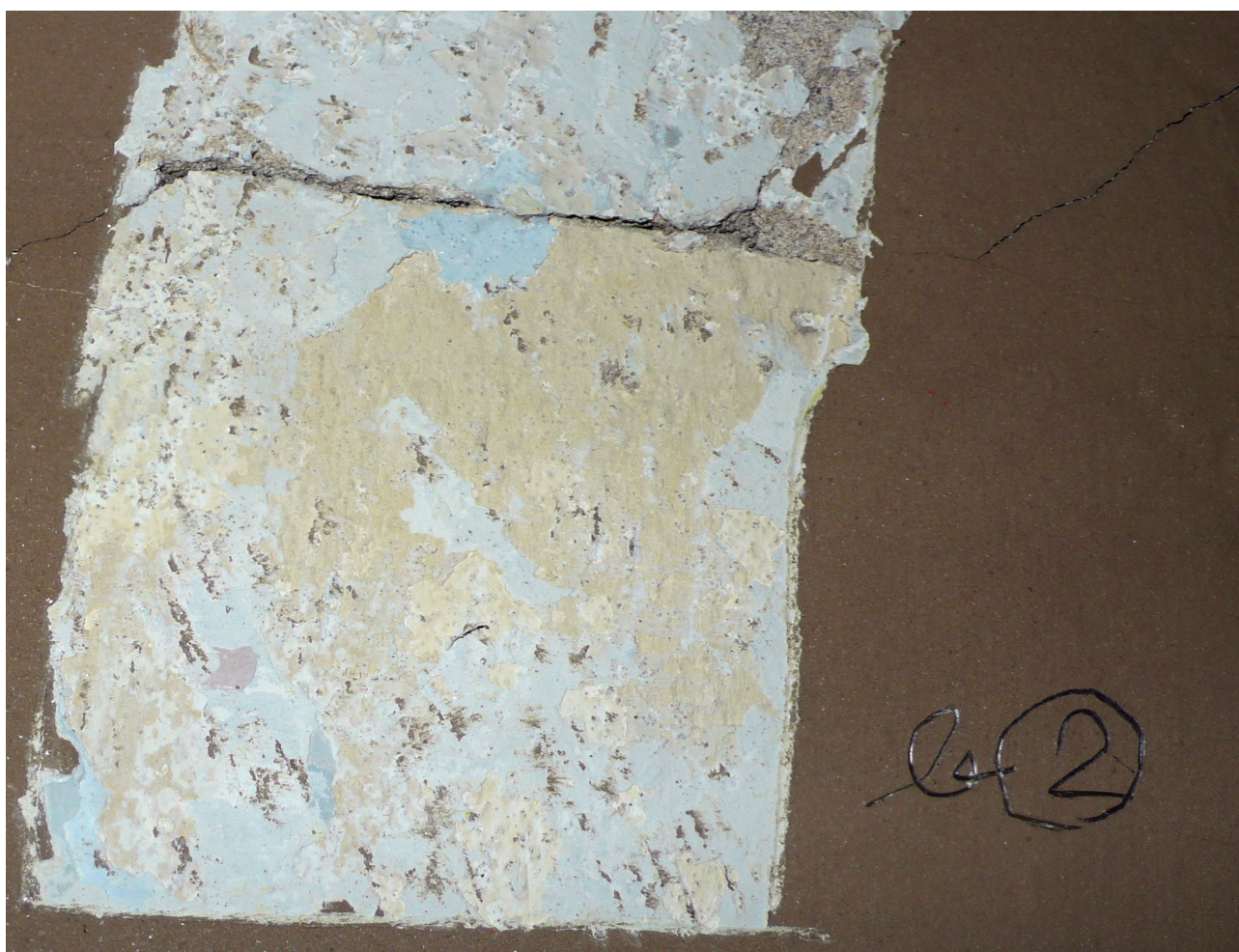
sonda 2 m 2.01b: zbytky výmaleb na klasicistní štukové vrstvě
