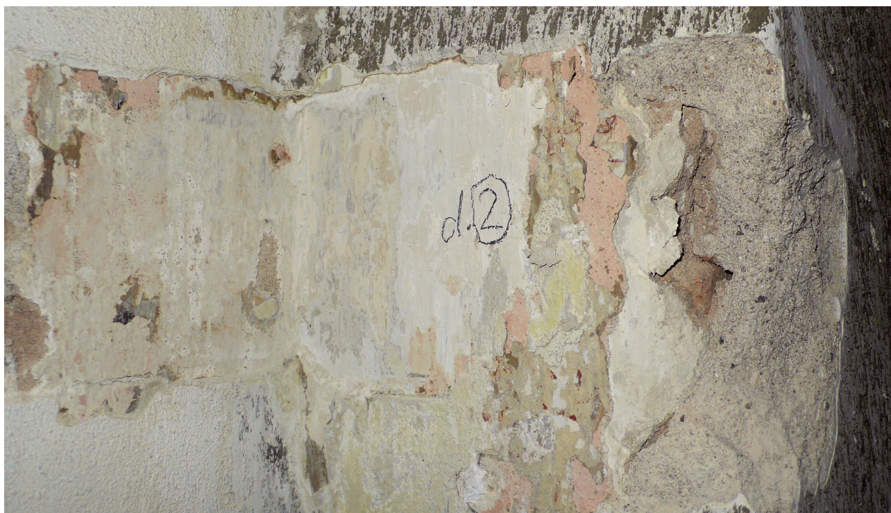
sonda 2 m 2.01d: zbytky výmaleb na klasicistní štukové vrstvě
