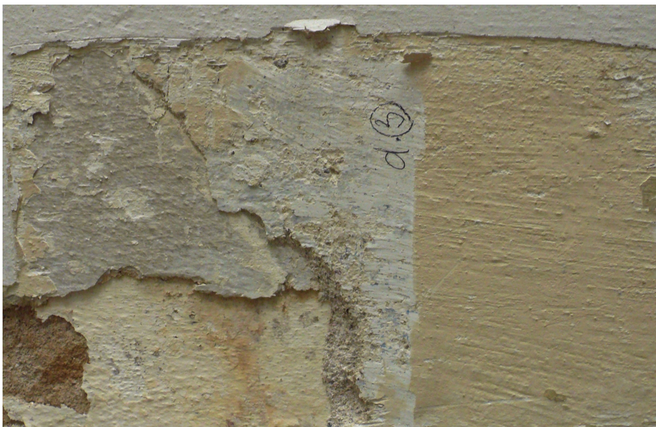
sonda 3 m 2.01d: zbytky výmalieb a štukové opravy na klasicistní štukové vrstvě
