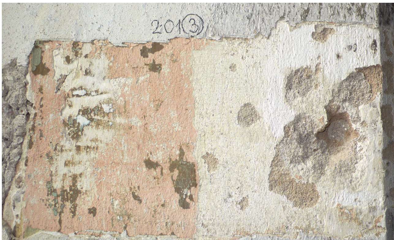
sonda 3 v okenní špaletě severního průčelí: zbytky výmaleb
