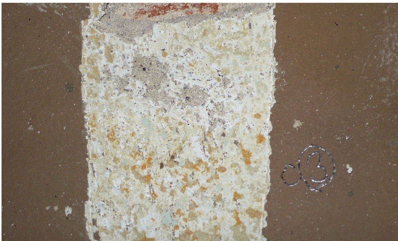
sonda 3 m 2.01c: zbytky výmalieb na klasicistní štukové vrstvě
