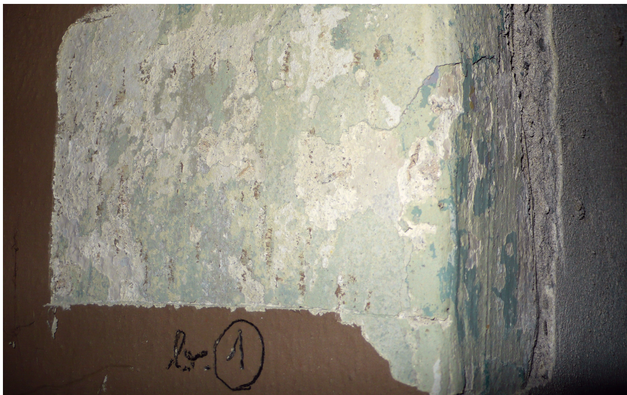
sonda 1 m 2.01b: zbytky výmaleb na klasicistní štukové vrstvě
