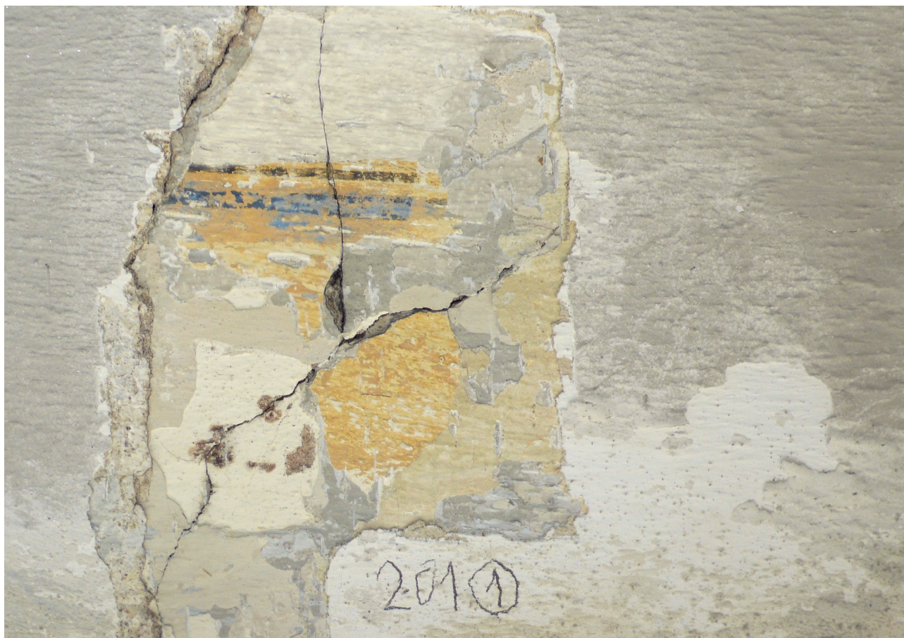
sonda 1 v míst 2.02: pod zbytky dekorativní malby šedé a světlé monochromní nátěry
