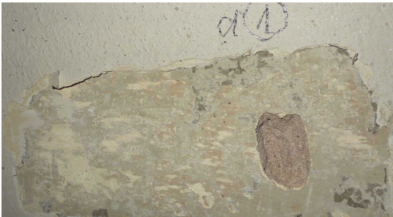
sonda 1 m 2.01d: zbytky výmaleb na klasicistní štukové vrstvě
