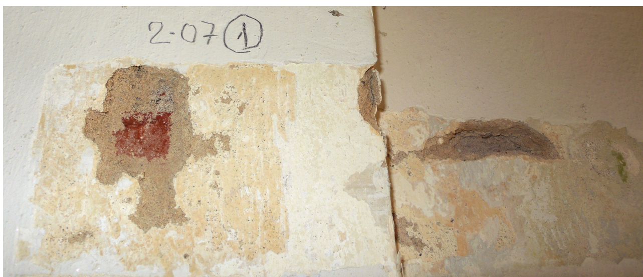
sonda 1 m2.07: starší monochromní nátěry na klasicistních omítkách
