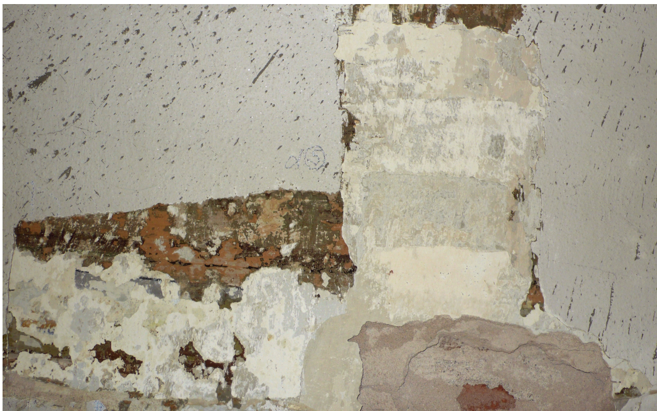
sonda 5 m 2.01d: zbytky dekorativní výmalby na klasicistní štukové vrstvě
